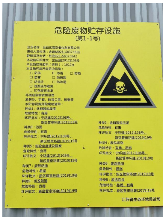
危险废物暂存间标识
